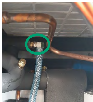
Abbildung 182: Ventil öffnen
