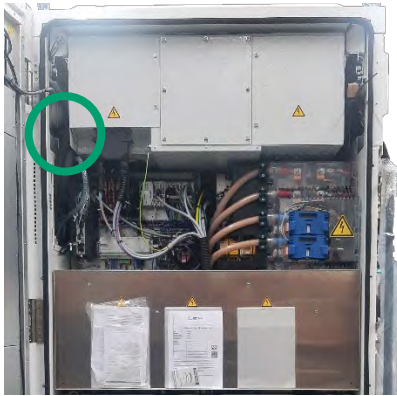
Abbildung 74: Position Rauchmelder - 1
