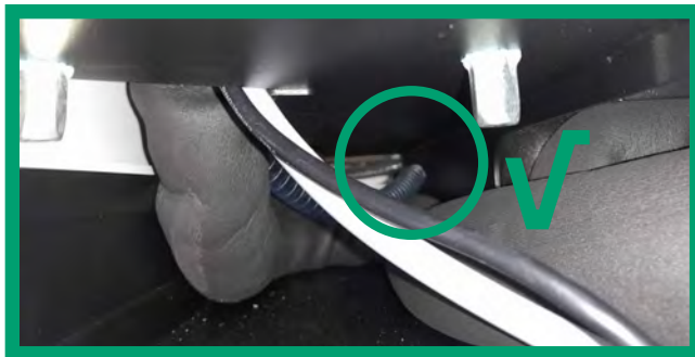
Abbildung 75: Sockelbereich auf Feuchtigkeit prüfen (Wechselrichterseite)
