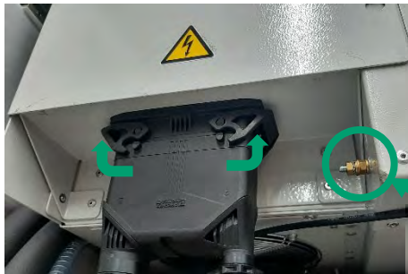
Abbildung 100: Kabel und Erdung demontieren
