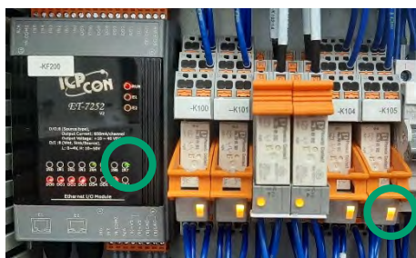
Abbildung 169: LED I/O Modul und Relais leuchten
