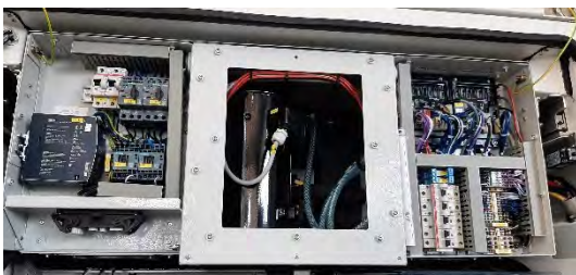
Abbildung 143: Kühlgerät ohne Abdeckblech – Wechselrichterseite - Rev02 und Rev03
