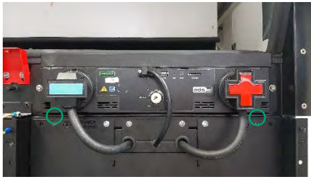
Abbildung 59: PE-Anschlüsse am Abdeckblech entfernen
