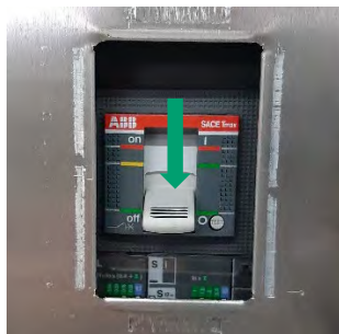
Abbildung 113: Hauptschalter „OFF“
