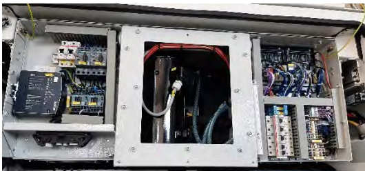
Abbildung 163: Kühlgerät ohne Abdeckblech (Abbildung exemplarisch)
