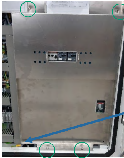
Abbildung 19: AC-EMV-Abdeckung demontieren
