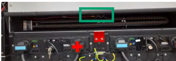
Abbildung 184: Position Temperaturfühler
