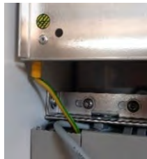
Abbildung 24: Erdungskabel Abdeckblech Wechselrichter
