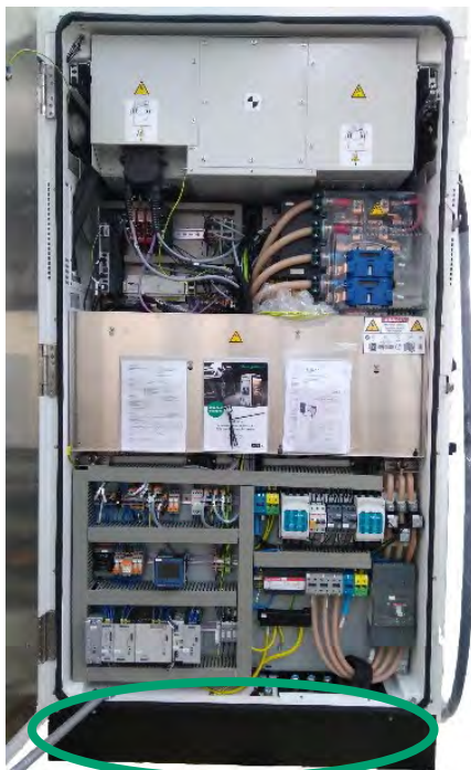
Abbildung 106: Flüssigkeit im Sockelbereich analysieren
