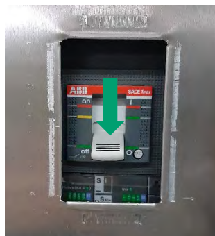
Abbildung 57: Hauptschalter in Position „off“
