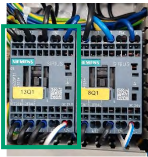
Abbildung 135: Relais für Kompressor tauschen – Rev02 und Rev03
