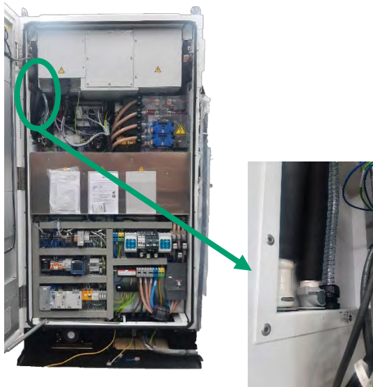
Abbildung 138: Kühlschläuche prüfen - Wechselrichterseite (Abbildung exemplarisch)
