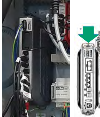
Abbildung 112: IPC am Taster abschalten
