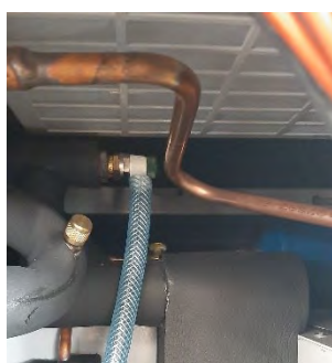
Abbildung 177: Entlüftungsventil
