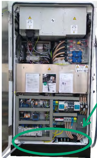
Abbildung 75: Sockelbereich auf Feuchtigkeit prüfen (Wechselrichterseite)
