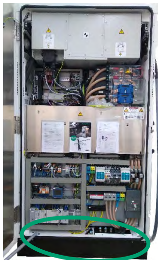
Abbildung 84: Sockelbereich auf Feuchtigkeit prüfen (Wechselrichterseite)
