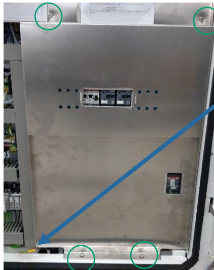
Abbildung 20: AC-EMV-Abdeckung montieren
