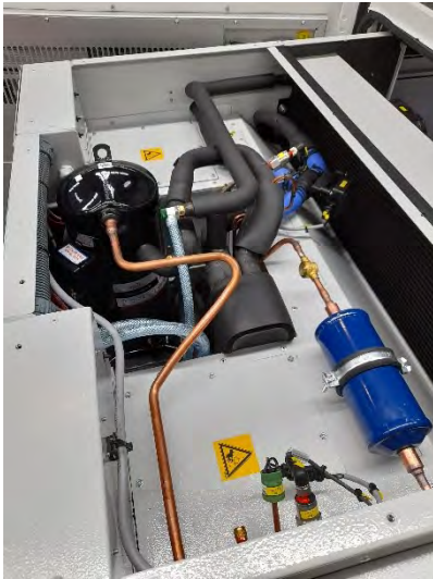
Abbildung 142: Kühlgerät ohne Abdeckblech von oben (Abbildung exemplarisch)
