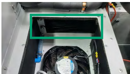
Abbildung 150: Kühlgerät ohne Abdeckblech von oben (Abbildung exemplarisch)
