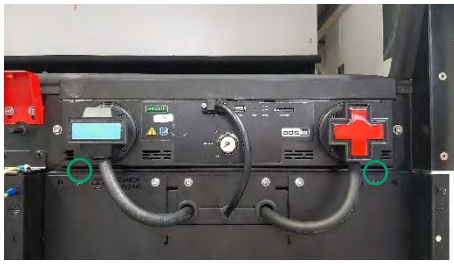
Abbildung 72: PE-Anschlüsse montieren
