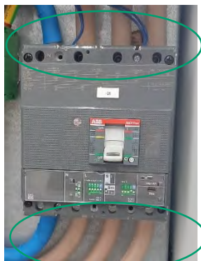
Abbildung 54: Anschlüsse Hauptschalter
