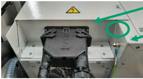
Abbildung 165: Kabel- und Erdung montieren
