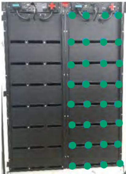
Abbildung 60: Abdeckblech demontieren (Ansicht: vollbestückte Variante)
