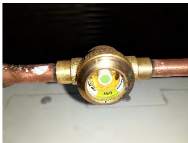
Abbildung 173: Kältemittel-Schauglas
