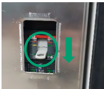
Abbildung 81: Hauptschalter „OFF“
