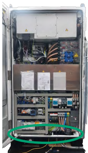
Abbildung 138: Kühlschläuche prüfen - Wechselrichterseite (Abbildung exemplarisch)
