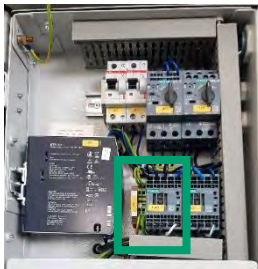
Abbildung 135: Relais für Kompressor tauschen – Rev02 und Rev03
